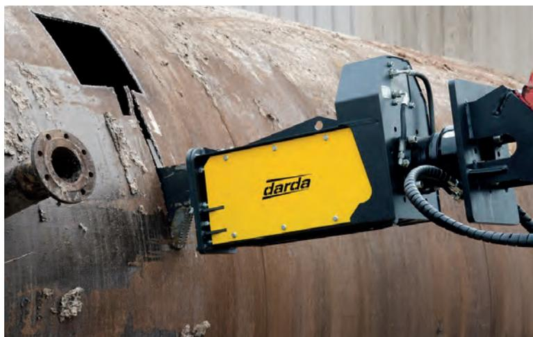
Dünnwandige Stahlobjekte (Silos, Tanks) lassen sich um ein Vielfaches schneller und effizienter mit Tankschneidern zerlegen, als mit reinen Schrottscheren
