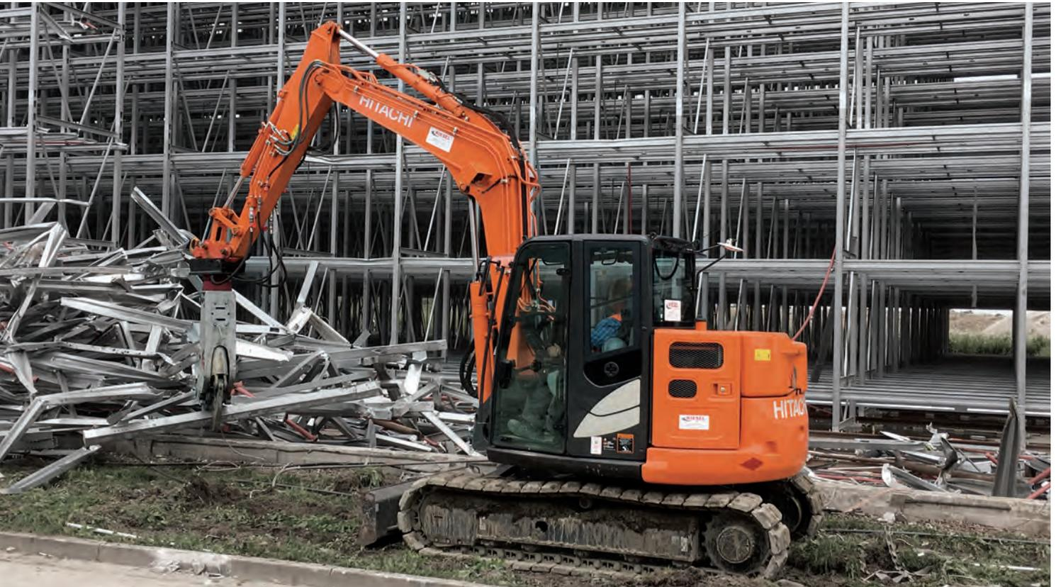
Leistung in der Kompaktklasse - DMS05 zerkleinert tonnenweise Stahlkonstruktionen
