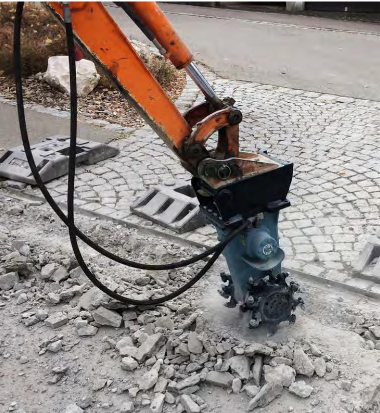
Feinfühliges, Präzises Arbeiten in erschütterungssensiblen Bereichen, über die gesamte Trommelbreite - mehr Meter in weniger Zeit mit Rockwheel Fräsen
